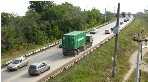
Рис. 5. Сдерживающие факторы на исследуемом участке: подъем и состав ТП
