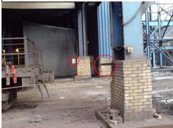
Рис. 5. Расположение RFID-считывателей на перегонах
